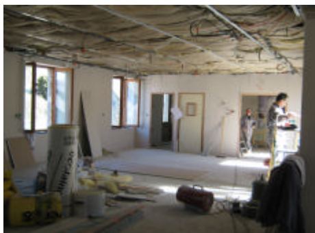
Travaux d'aménagements de la salle de motricité
